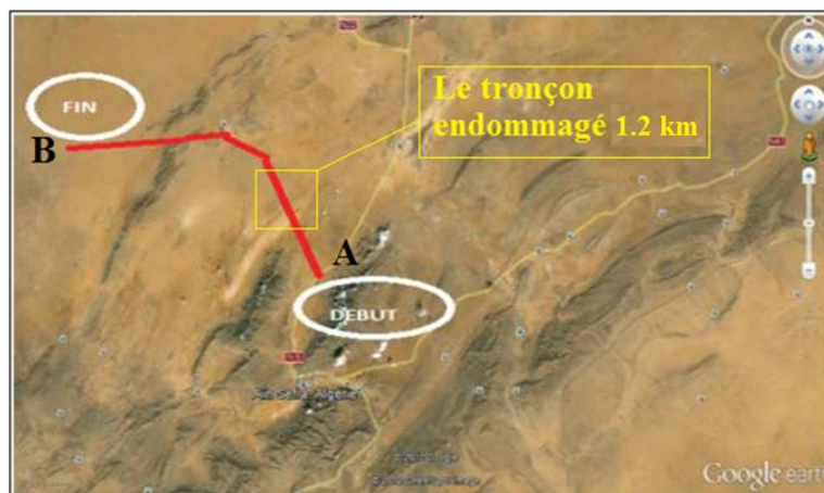
Figure 1 : Tracé en plan de la chaussée autoroutière (2*3 voies) montrant le tronçon endommagé qui est concerné des travaux de réparation.
