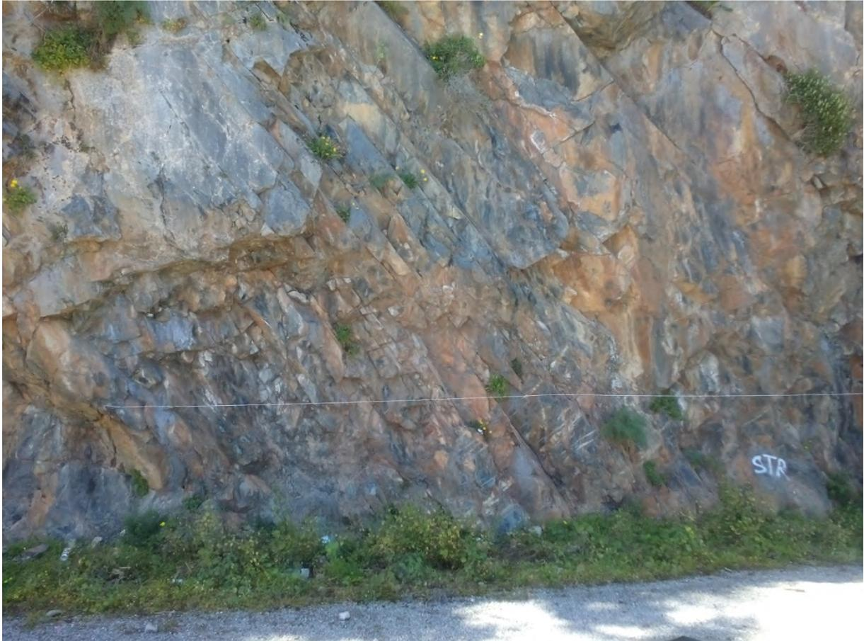
**Fig I.1:** Structure géométrique du massif rocheux de calcaire à la falaise d'Aokas (Bejaia).
