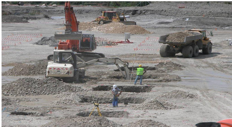
Fig 1.12: Amélioration d'un terrain par induction hydraulique (Substitution du sol par du gravier dans un chantier à Saint Martin d'Hères en 2006, France).
