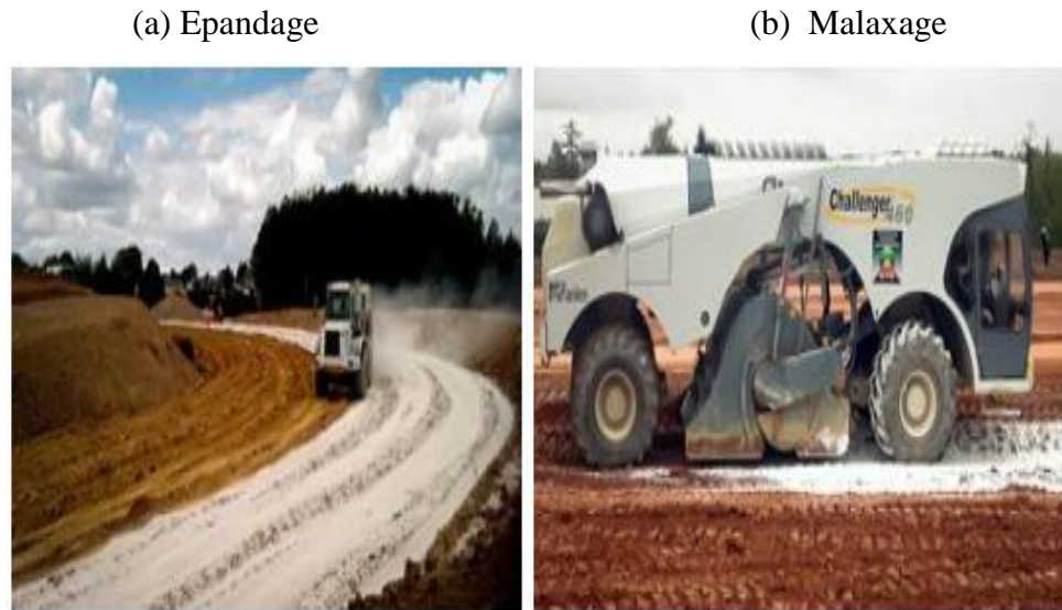
Fig. 1.15 : Chantier de traitement d'un sol à la chaux [France ,2009]
