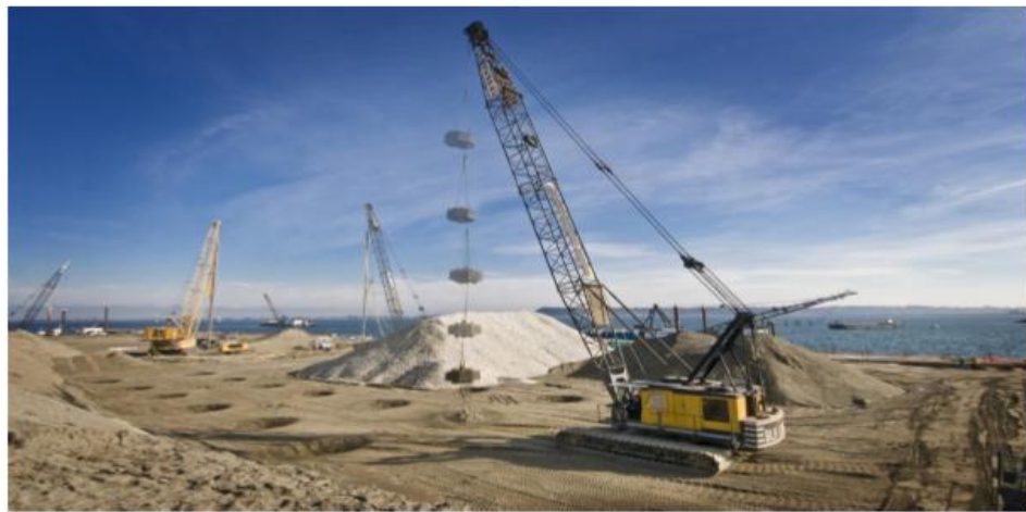
Fig. 1.10 : Chantier d'un compactage dynamique profond.
