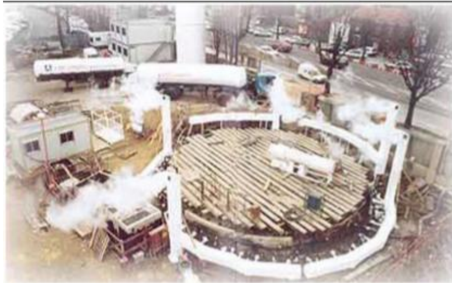
Fig. 1.14 : Chantier utilisant la congélation du sol. Killer France (2013)
