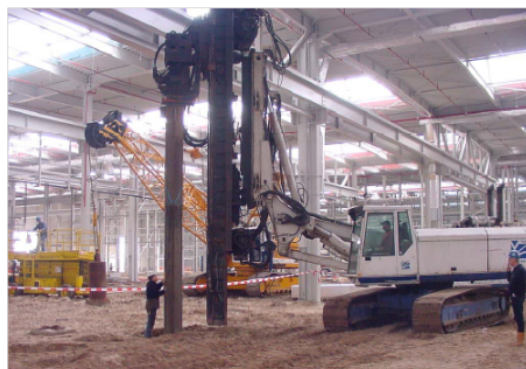
Fig. I.6 — Densification par vibro-compactage (Cas d'un sable lâche ayant 5m d'épaisseur d'un hall industriel construit en Belgique) ( De Cock and Bottiau 2004 p.47 ).
