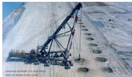
Fig. I.3 — Densification d'un terrain par compactage dynamique à très haute énergie (4000 T.m) (Cas réel de l'aéroport de Nice 1978, France, D'après Menard 2010 p.48 ☞ ).
