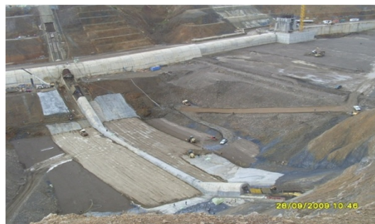
Fig. I.1 — Stabilisation par compactage de surface (Cas d'une digue de barrage en terre de Kef-Eddir construit à Tipaza en 2009, Algérie).
