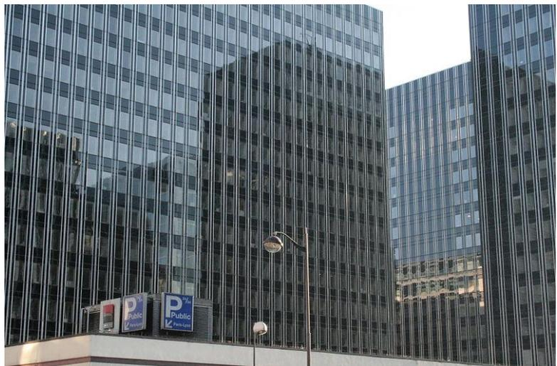
La façade rideau (ou mur rideau) est une façade légère qui assure la fermeture de l'enveloppe d'un bâtiment sans participer à sa stabilité. Ce type de façade se constitue d'une ossature – montants et traverses – le plus souvent en profilés aluminium, et de remplissages vitrés ou opaques montés sur celle-ci.
