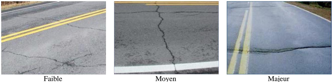
*Figure III.24 – Gravité des fissures transversales (MTQ-AIMQ 2002).*
