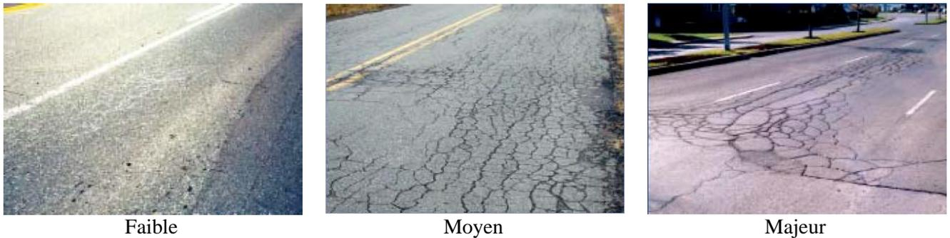
Figure III.28 – Gravité des fissures en carrelage « Faiençage » (MTQ-AIMQ 2002).
