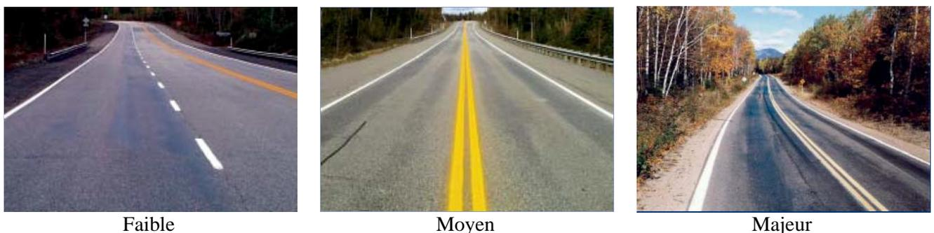
Figure III.33 – Gravité de ressuage (MTQ-AIMQ 2002).
