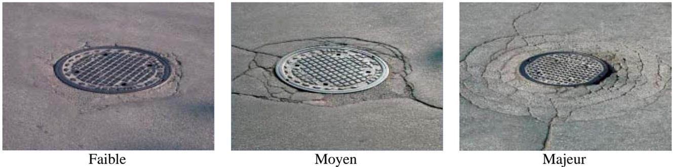
**Figure III.36** – Gravité de fissuration autour des regards et des puisards (MTQ-AIMQ 2002).
