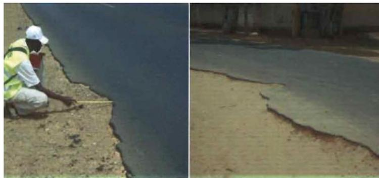
Figure III.40 – Une épaufrure sur une chaussée rigide.
