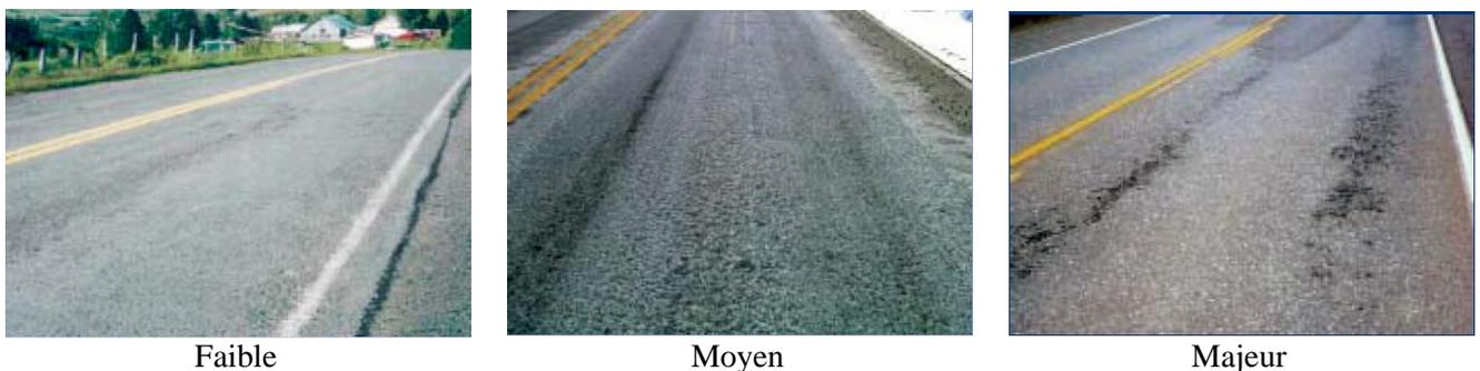
*Figure III.30 – Gravité de désenrobage (MTQ-AIMQ 2002).*
