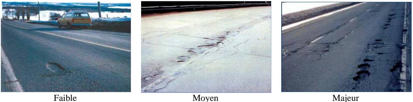
**Figure III.31** – Gravité de pelade « *arrachement par plaques* » ([MTQ-AIMQ 2002](#)).
