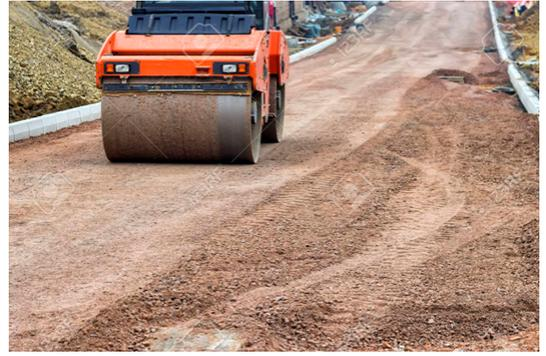
La quantification de la masse de l'eau et du sol à utiliser dans un ouvrage de remblai (digue de barrage, voies routières ou ferroviaires, etc.) peut se faire par rapport aux références de compactage [densité sèche maximale (équation I.1) et Teneur en eau optimale (équation I.2)] déterminées au niveau du laboratoire par l'essai de Proctor modifier (PM) à savoir :
