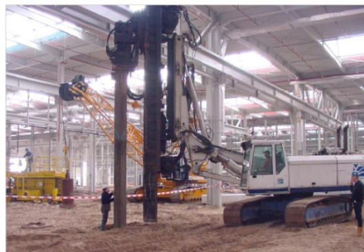
L'énergie vibratoire est transmise sur toute la longueur du profilé et provoquant le compactage du sol en place, sans qu'un matériau de remplacement soit nécessaire. *Ce type de densification fonctionne*
