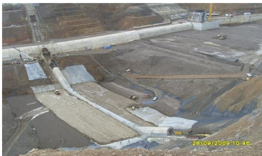
**Fig. III.1** — Stabilisation par compactage de surface (Cas d'une digue de barrage en terre de Kef-Eddir construit à Tipaza en 2009, Algérie).
