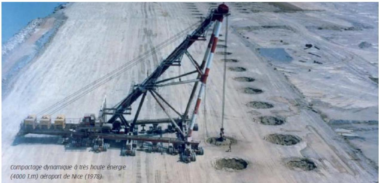
**Fig. III.3** — Densification d'un terrain par compactage dynamique à très haute énergie (4000 T.m) (Cas réel de l'aéroport de Nice 1978, France).
