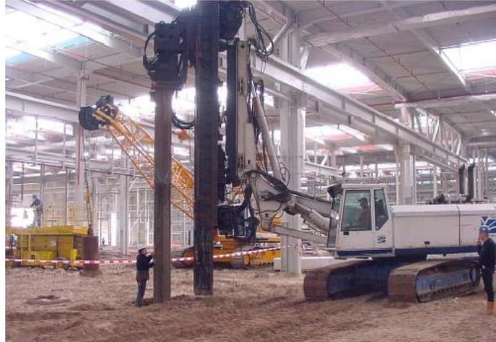
Fig. III.6 — Densification par vibrocompactage (Cas d'un sable lâche ayant 5m d'épaisseur d'un hall industriel construit en Belgique) (De Cock and Bottiau, 2004).
