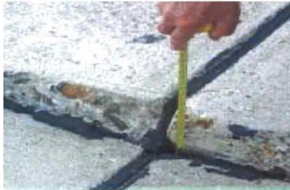
*Figure III.41 – Décalage de dalle d'une chaussée rigide.*
