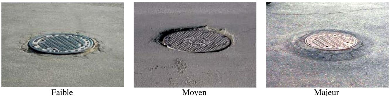
**Figure III.37** – Gravité de dénivellation des regards et des puisards (MTQ-AIMQ 2002).
