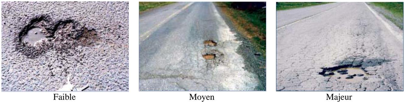
Figure III.32 – Gravité du nid-de-poule (MTQ-AIMQ 2002).
