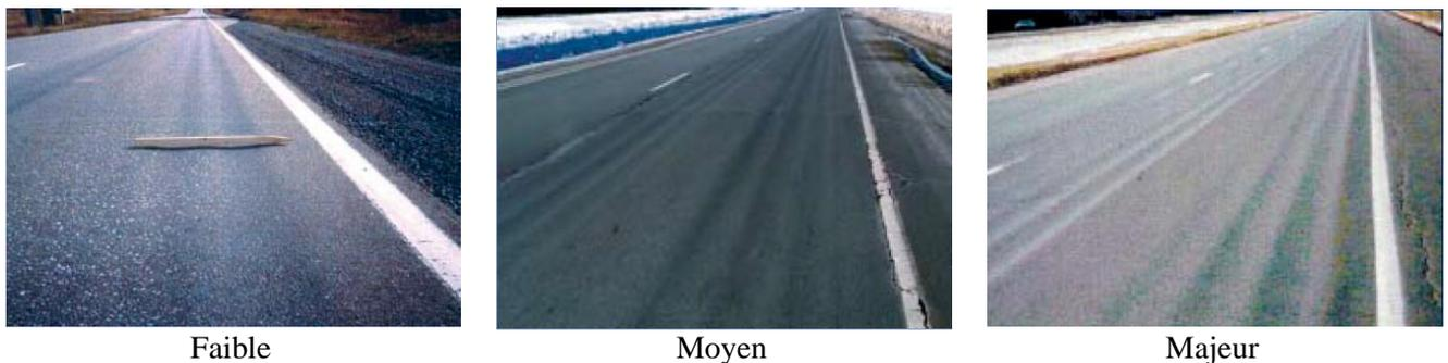
*Figure III.19 – Gravité d'une ornière à faible rayon (MTQ-AIMQ 2002).*
