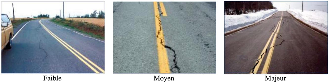
Figure III.27 – Gravité des fissures de gel (MTQ-AIMQ 2002).
