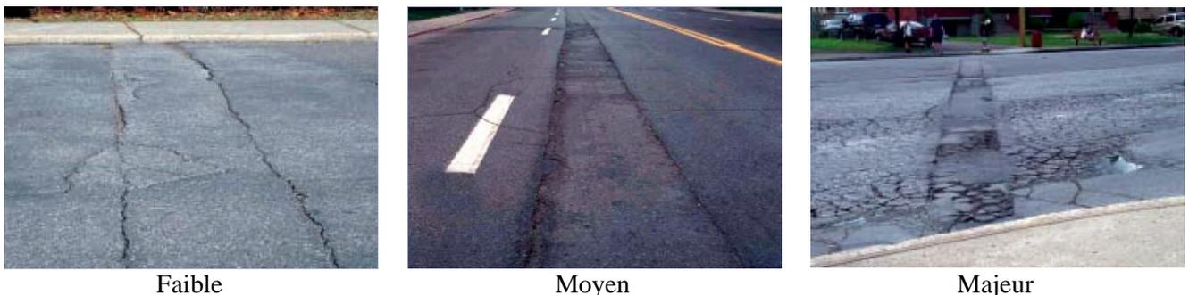
*Figure III.38 – Gravité de coupe et tranchée (MTQ-AIMQ 2002).*
