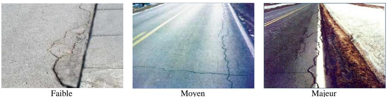
Figure III.29 – Gravité des fissures en rive (MTQ-AIMQ 2002).
