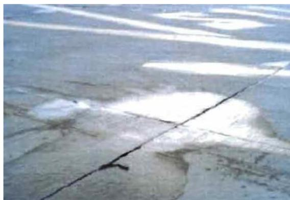
*Figure III.41 – Ejection de matériaux (pompage) en chaussée rigide.*
