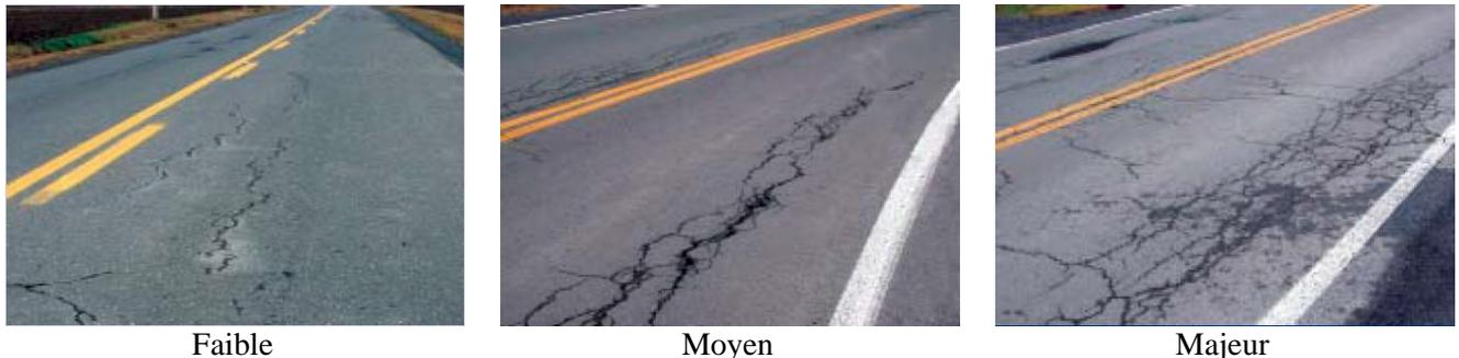
**Figure III.25** – Gravité des fissures longitudinales en piste de roues (*MTQ-AIMQ 2002*).
