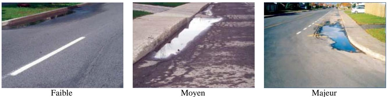
*Figure III.23 – Gravité d'un désordre de profil (MTQ-AIMQ 2002).*
