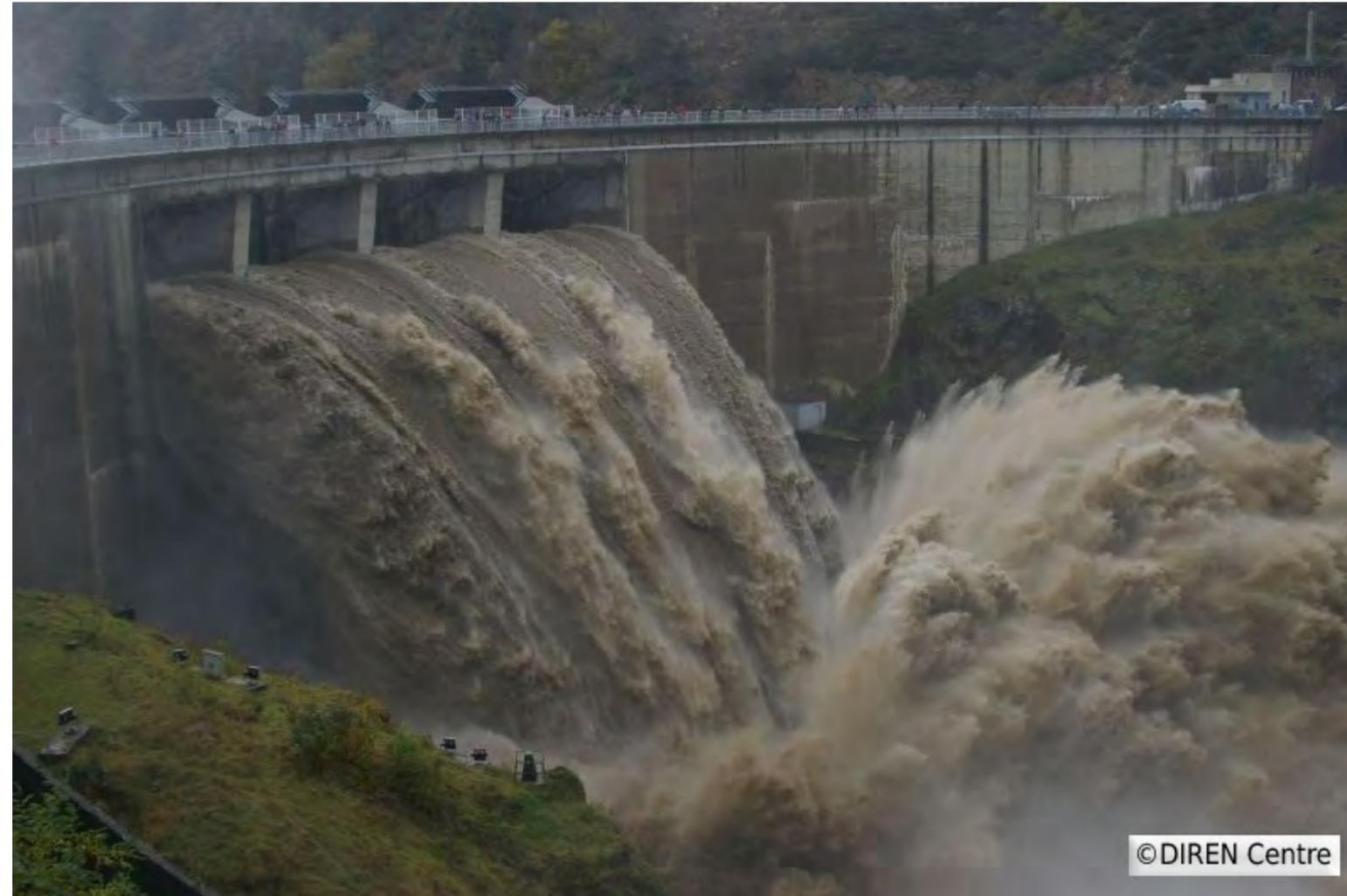
Crue de la Loire au barrage de Grangent en novembre 2008 : chute et ressaut hydraulique (régime rapidement varié)
