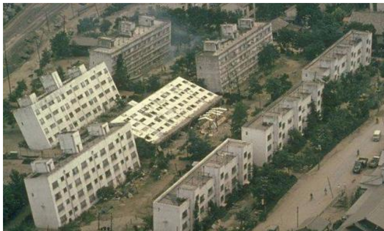
Fig. 2.7 – Liquéfaction d'un sol dû à un séisme
