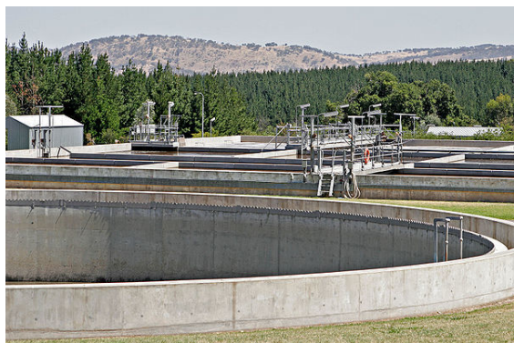
Usine de traitement des eaux usées en Australie.
