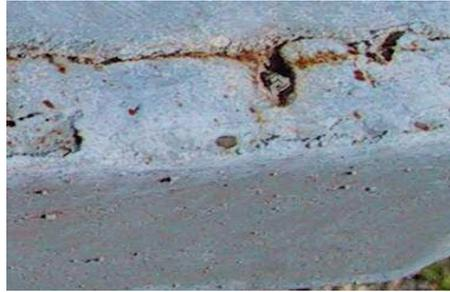
◆ **Corrosion par piqûres** : Cette forme de corrosion est particulièrement insidieuse. L'attaque se limite à des piqûres, très localisées et pouvant progresser très rapidement en profondeur, alors que le reste de la surface reste indemne. L'installation peut être perforée en quelques jours sans qu'une perte de poids appréciable de la structure apparaisse.
